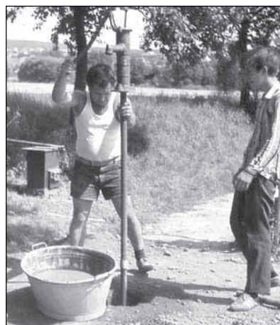
Vrtání studny v Gisselbergu. Tam, kde v dosažitelném podloží nejsou kameny, jsme mohli vrtat lehkým „náčiním“.
