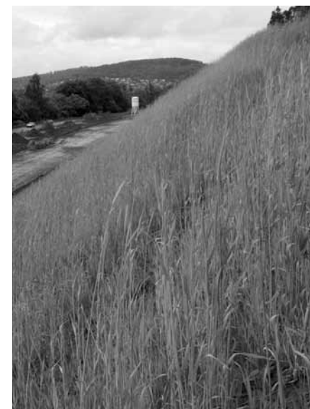
Žito použité ke stabilizaci dálničního náspu.
