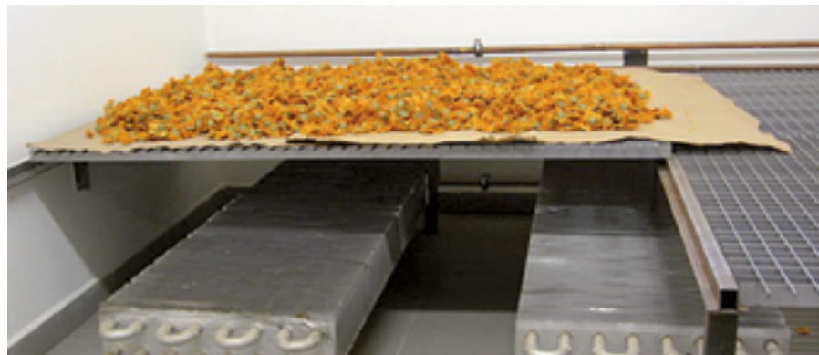
Roštová sušárna – detail umístění tepelných výměníků
